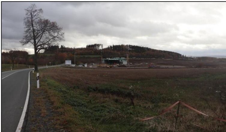
Abbildung 10: Vor-Ort Aufnahme des Beispielgebietes Oberlosa 1 zeigt große Freiflächen und die beginnenden Bauarbeiten im Hintergrund.
